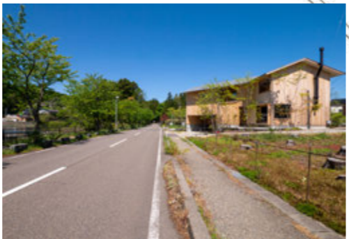
風景に溶け込む佇まいをつくるために、時を纏う素材の杉を外壁材に採用して、無塗装で張ることにより、時間の変化を感じることができる建築としている。
