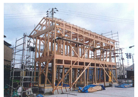
軸組在来工法による建て方
