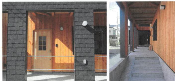
軒下：雪国の風雪の吹き込みを和らげる 軒下空間：コンクリート土間
