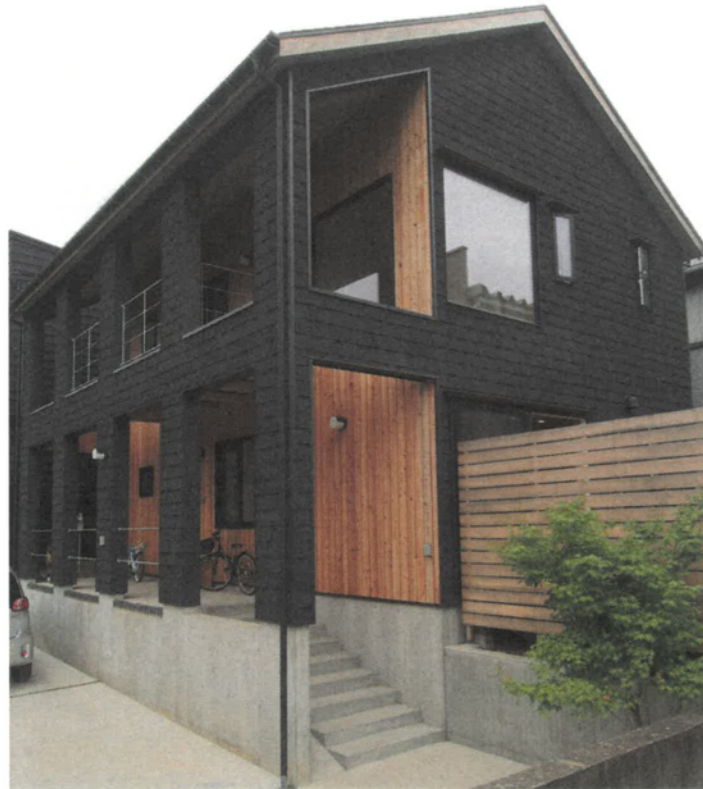
北側外観：雪国には欠かせない「雪かき道具」を玄関先に立てかけられる 外観はアスファルトシングルブラックを使用 アクセントとして唐松を用いて、木材の経年変化を楽しめるようにした
